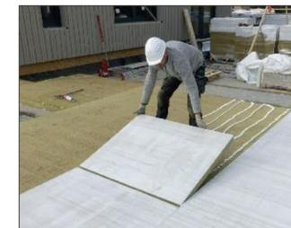
des Dämmsystems „Georock 038“. Laut Windlastberechnung konnte die dreilagige Dämmung durch Verklebung ausreichend lagegesichert werden. Zu einer belastbaren Nutzschiene wurden „Solarrock“ Dämmplatten in 60 mm Dicke verklebt. Ausgerüstet mit
