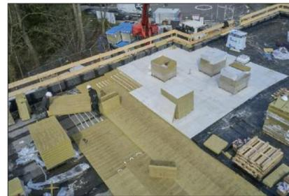
Wärmedämmung, Gefälledachdämmung und abschließende Nutzdachdämmung wurden auf einer Teilfläche des Daches zunächst als optimale Abstellfläche für angelieferte Paletten komplett verlegt. Ausgehend von dieser „Lagerinsel“ erschlossen sich die Dachdecker die übrige Dachfläche.
