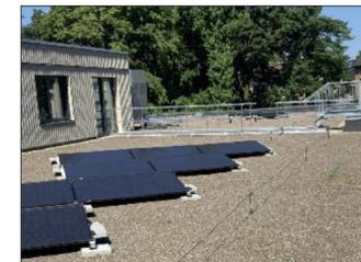
Auch die Lasten der Ständer für einzelne PV-Module oder vollständig aufgebrachte PV-Anlagen trägt eine Flachdachdämmung mit der neuen „Solarrock“ zuverlässig ab.
