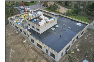
Rund 1.200 m<sup>2</sup> Dachfläche wurden auf diesem Kita-Neubau in Hilden mit nichtbrennbaren Systemen von ROCKWOOL gedämmt.
