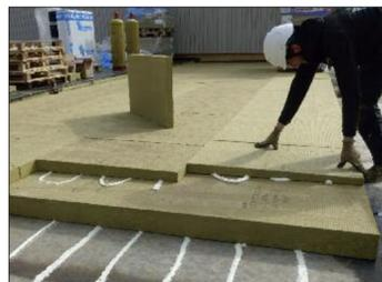
Zur Wärmedämmung wurden zunächst „Hardrock 038“ Dämmplatten in einer Dicke von 120 mm auf der Elastomerbitumen-Dampfsperbahn streifenweise verklebt. Darüber schufen die Dachdecker das vorgeschriebene Gefälle von 2 % zu den Entwässerungspunkten mit Hilfe
